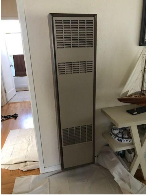
Low-Efficiency DHE Honeywell 867.7336
